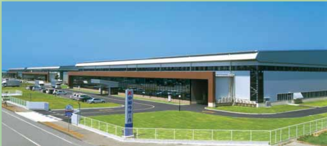
第三工場（右側の建物が完成した第三工場3号棟です）
